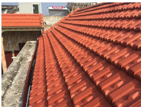
Hình 39 Mái ngói được sử dụng trong hệ thống lấy nước mưa
