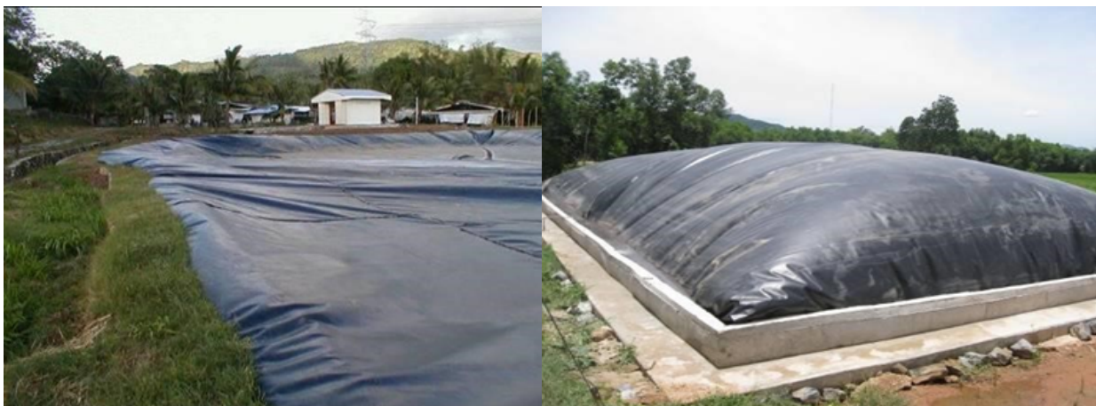
Hình 5 Thiết bị KSH bằng vật liệu HDPE
