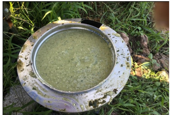
Hình 26 Mô hình thiết bị lên men yếm khí (đồng phân huỷ) 2m 3 đặt tại xã Lam Điền
