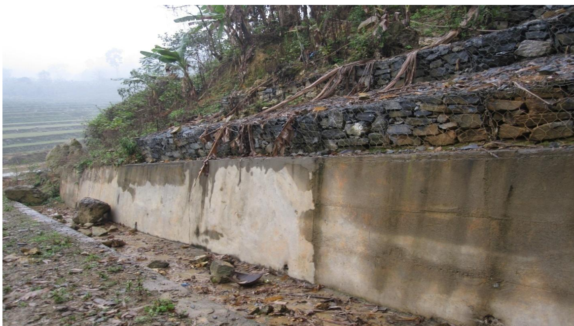
Hình 15: Kè chống sạt lở tại xã Quang Thành, Huyện Nguyên Bình, Tỉnh Cao Bằng
