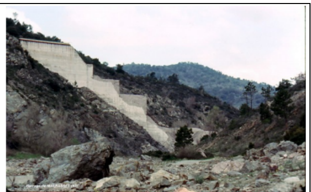
Đập Malpasset tại Pháp sau khi xảy ra sự cố
