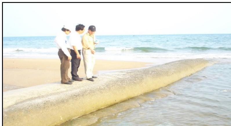
Hình 4-6: Túi cát tạo kè mềm tạo bãi
