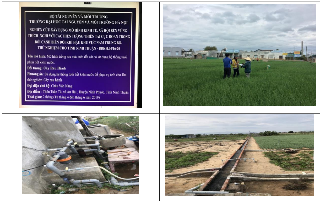
Hình 2. 1. Một số mô hình ảnh trong quá trình xây dựng cơ sở hạ tầng
