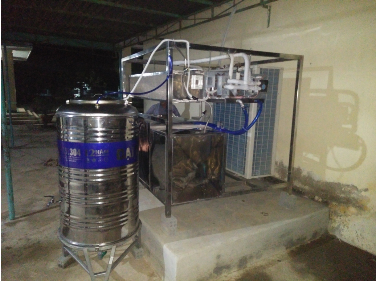
Hình 3.80: Hệ thống làm lạnh tách ẩm 200 L/ngày có trang bị bình chứa nước sạch
