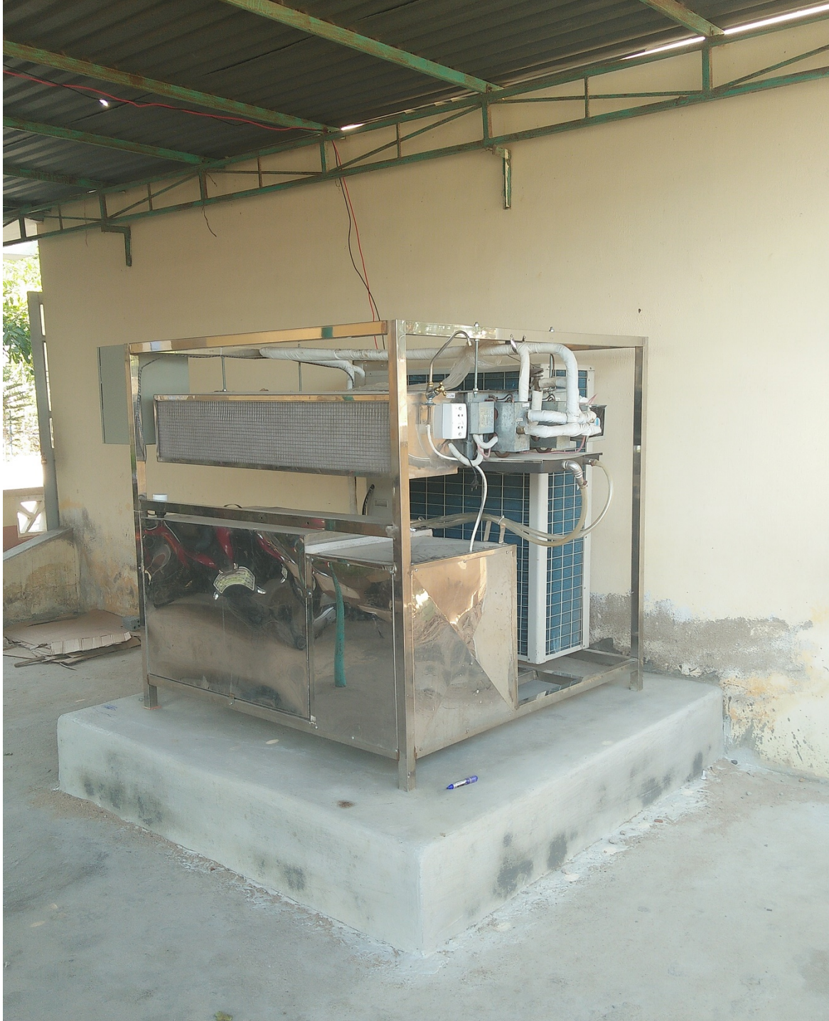
Hình 3.69: Công tác xây lắp nền móng và lắp đặt hệ thống tách ẩm 200 L/ngày.
