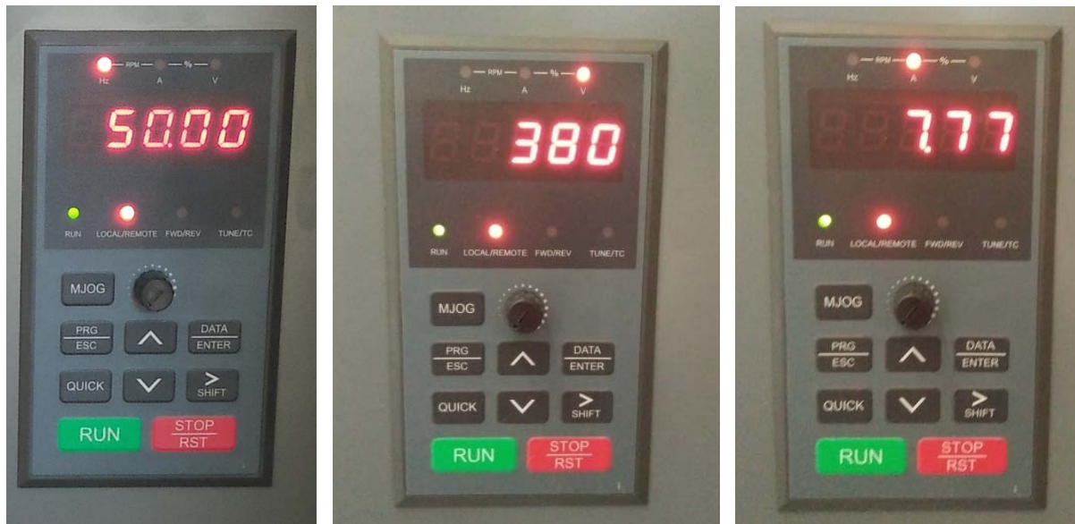
Hình 3.74: Thông số vận hành hệ thống tách ẩm 200L/ngày
