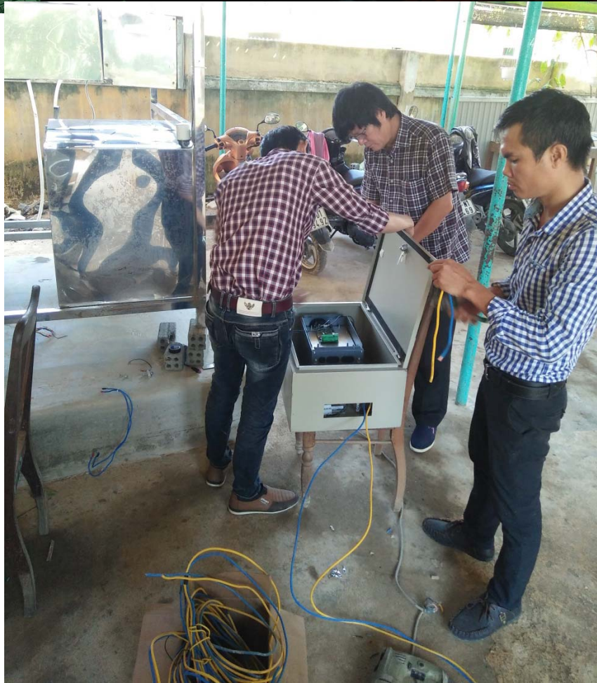
Hình 3.70: Công tác kiểm tra và lắp đặt bộ điều khiển hệ thống tách ẩm 200 L/ngày
