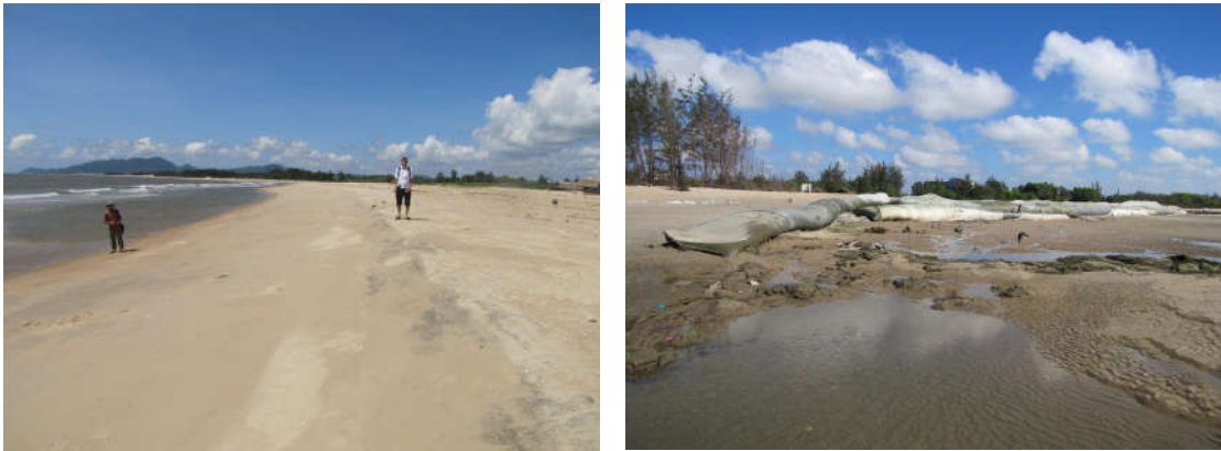
Hình 5.29. Bãi biển phía ngoài hệ thống các bao stabiplage ở phía tây cửa Lộc An đã trở nên dốc hơn (trái) và các bao stabiplage bị phá hủy ngay tại cửa Lộc An (ảnh Vũ Văn Phái, 2012)
