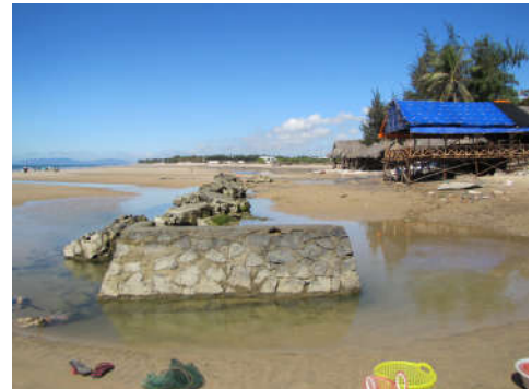
Hình 1.21. Kè bảo vệ bờ bị phá hủy nằm trên bãi biển ở Hồ Tràm, Xuyên Mộc (trái) và rừng phi lao bị đổ ở khu du lịch Chí Linh, Vũng Tàu (phải) (ảnh Vũ Văn Phái, 2/2012)
