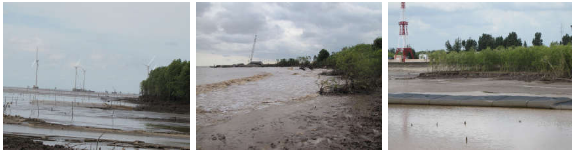
Hình 3.42. Xói lở bờ biển xã Vĩnh Trạch Đông (trái), Gành Hào (giữa) và kè bảo vệ bờ bằng công nghệ stabiplage ở Nhà Mát (phải) (ảnh Vũ Văn Phái, 2012)
