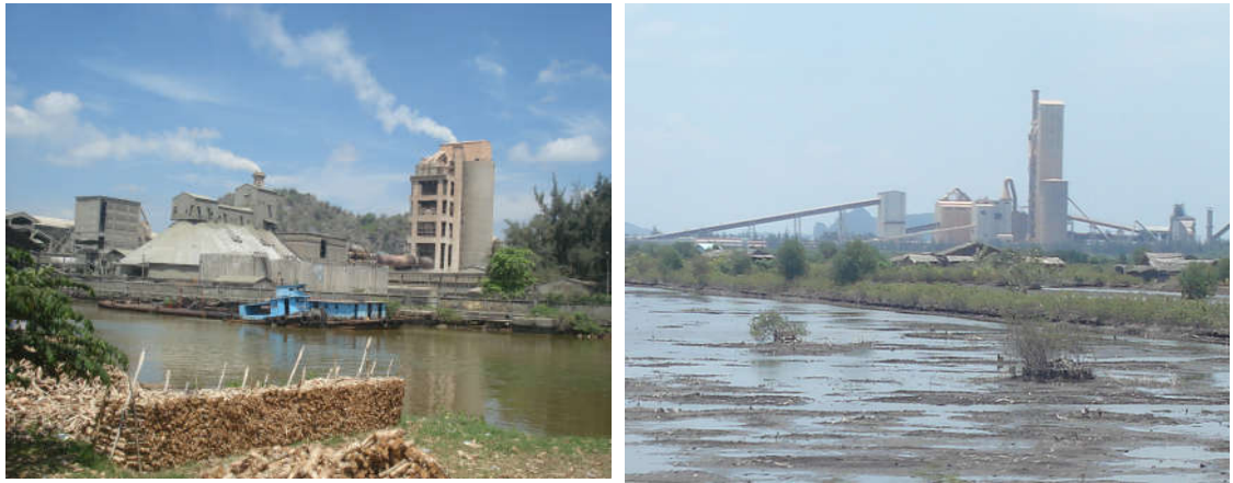
Hình 5.10. Nhà máy xi măng Kiên Lương (trái) và nhà máy xi măng của Công ty Holcim (phải) (Ảnh Vũ Văn Phái, 2009)
