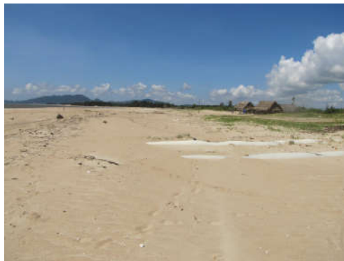
Hình 5.28. Hệ thống kè mềm bằng công nghệ stabiplage đặt vuông góc với đường bờ ở phía tây cửa Lộc An (Bà Rịa-Vũng Tàu) được xây dựng năm 2005 (trái) và đặt song song với đường bờ như một tường chắn sóng mới được xây dựng ở khu Nhà Mát (Bạc Liêu) (ảnh Vũ Văn Phái, 2012)
