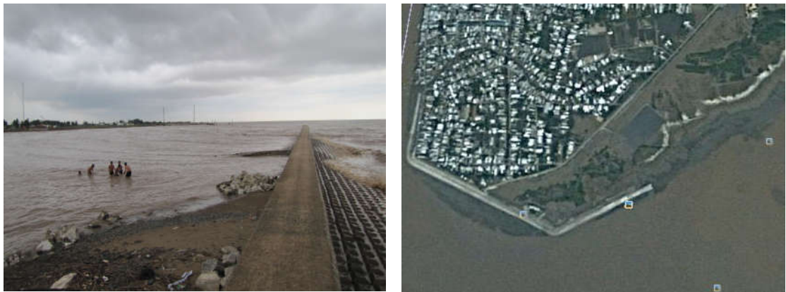
Hình 4.35. Đê chắn sóng ở Gành Hào (trái) (ảnh Vũ Văn Phái, 2012) và quan sát từ Google Earth (phải)
