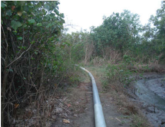
Hình 4.31. Đường ống dẫn cát hút từ bãi biển để san lấp khu phía nam cầu Tô Châu, Hà Tiên (trái, ảnh Vũ Văn Phái, 2008) và sà lan khai thác cát ở cửa (phải, ảnh Vũ Văn Phái, 2013)
