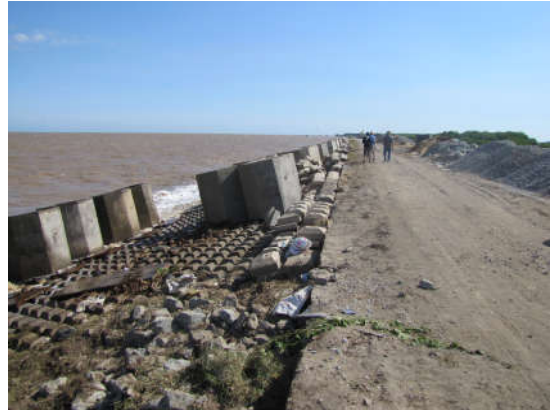
Hình 5.16. Xói lở đe dọa phá hủy đường giao thông ở phía bắc mũi Ba Kiềm (trái) và đê biển Gò Công Đông (phải) (ảnh Vũ Văn Phái, 2012)
