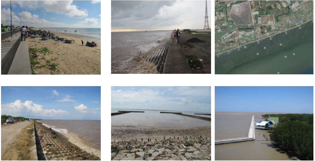
Hình 4.34. Các công trình bảo vệ bờ biển: tường biển ở Phước Hải (trên, trái) và ở Gành Hào (trên, giữa); kè mỏ ở Cần Giò (trên, phải, nguồn Google Earth); đê biển ở Gò Công Đông (dưới, trái); kè chữ T ở Sóc Trăng (dưới, giữa) và đê chắn sóng ở mũi Cà Mau (dưới, phải)
