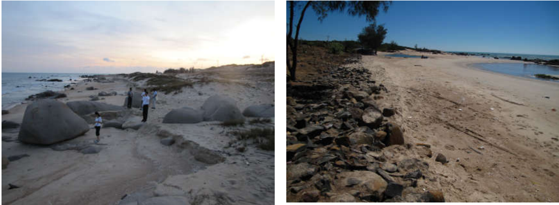
Hình 3.27. Đoạn bờ đá thấp đang bị xói lở làm lộ ra các khối đá granit bị mài mòn (trái) và phải kê đá để bảo vệ (phải) ở khu vực mũi Ba Kiềm, tỉnh Bà Rịa-Vũng Tàu (ảnh Vũ Văn Phái, năm 2012 và 2010)
