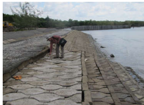
Hình 5.27. Sập đổ do bị xói chân tường ở Hồ Tràm, Bà Rịa-Vũng Tàu (trái, ảnh Đoàn Thu Phương, 2012) và chân kè đang bị xói ở bờ biển phía trong hòn Đá Bạc, Cà Mau (phải, ảnh Vũ Văn Phái, 2010)
