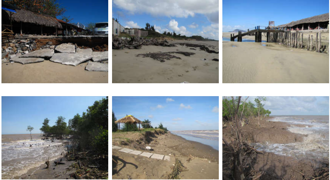
Hình 5.14. Xói lở làm sập đổ các công trình ở Hồ Tràm (trên, trái), Cửa Lấp (trên, giữa) và khu Paradise (trên, phải) đều ở Bà Rịa-Vũng Tàu; làm mất đất ở Gò Công Đông, Tiền Giang (dưới, trái), ở Thanh Hải, Thạnh Phú, Bến Tre (dưới, giữa) và Rạch Gốc, Ngọc Hiển, Cà Mau (dưới, phải) (ảnh Vũ Văn Phái, 2012)
