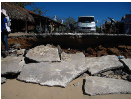
Hình 5.27. Sập đổ do bị xói chân tường ở Hồ Tràm, Bà Rịa-Vũng Tàu (trái, ảnh Đoàn Thu Phương, 2012) và chân kè đang bị xói ở bờ biển phía trong hòn Đá Bạc, Cà Mau (phải, ảnh Vũ Văn Phái, 2010)
