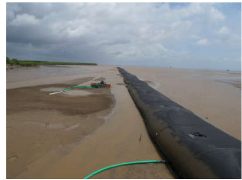
Hình 5.28. Hệ thống kè mềm bằng công nghệ stabiplage đặt vuông góc với đường bờ ở phía tây cửa Lộc An (Bà Rịa-Vũng Tàu) được xây dựng năm 2005 (trái) và đặt song song với đường bờ như một tường chắn sóng mới được xây dựng ở khu Nhà Mát (Bạc Liêu) (ảnh Vũ Văn Phái, 2012)
