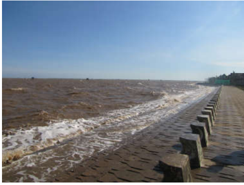
Hình 5.26. Kè lát mái ở khu du lịch Tân Thành, Tiền Giang (trái) và tường biển được xây dựng vào năm 2010 ở Phước Hải, Bà Rịa-Vũng Tàu (phải) (ảnh Vũ Văn Phái, 2012)
