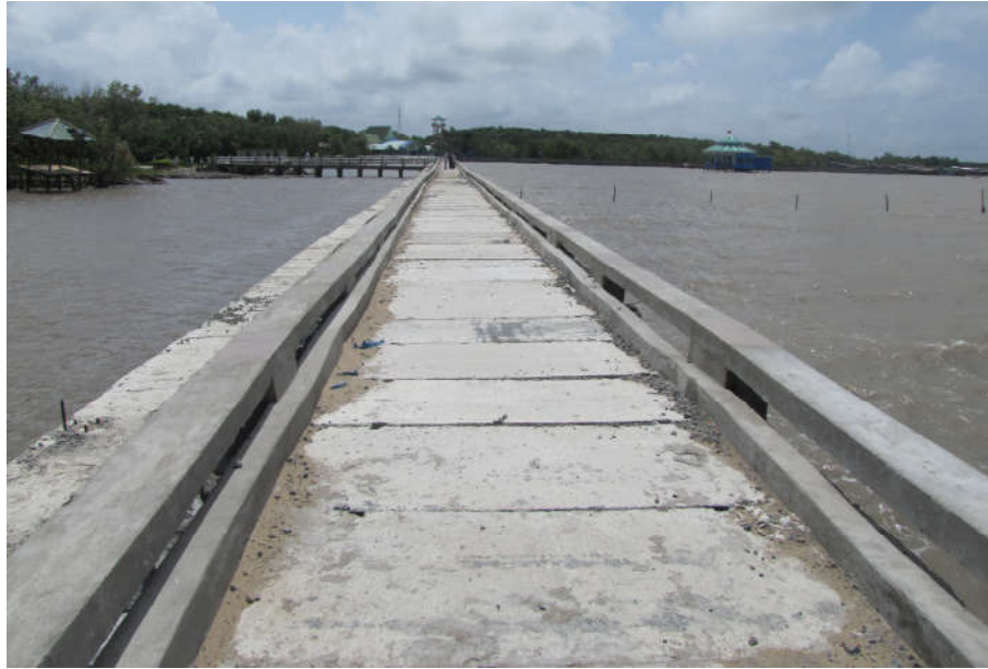
Hình 5.30. Đê chắn sóng mới được hoàn thành vào năm 2011 ở mũi Cà Mau (ảnh Vũ Văn Phái, 2012)
