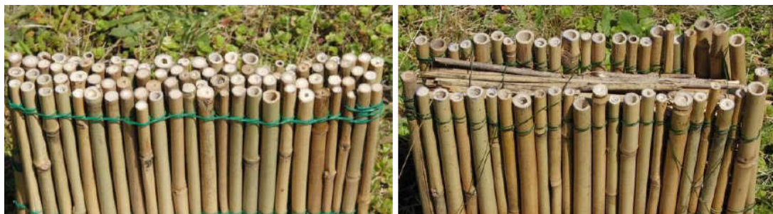
Hình 5.36. Kết cấu hàng rào tre dày nhất nhìn từ trên xuống (trái) và chèn vật liệu khác vào giữa 2 hàng tre (phải) [1]
