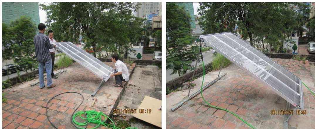
Hình 4.26. Lắp đặt và chạy thử nghiệm tại Trung tâm Tư vấn và CNMT
