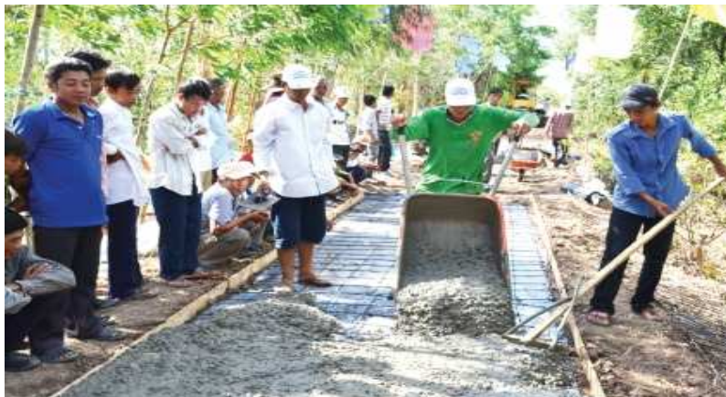
Hình 3.10. Xây dựng đường nông thôn ở ĐBSCL-Ảnh Internet
