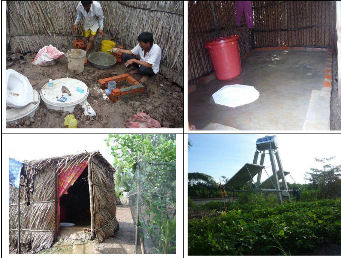
Hình 4.30. Thi công xây dựng bể tự hoại composite
