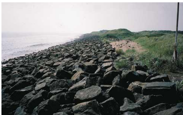
Hình 5. 16. Lớp kè mái đá nghiêng ở mặt trước cồn cát, mặc dù làm an toàn cồn cát trong thời gian dài, tác động đáng kể đến cảnh quan và hệ sinh thái ven biển
