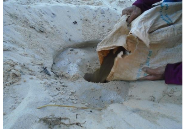
Bước 4. Nhồi hỗn hợp đất sét vào lỗ cột sét tạo bấc thấm
