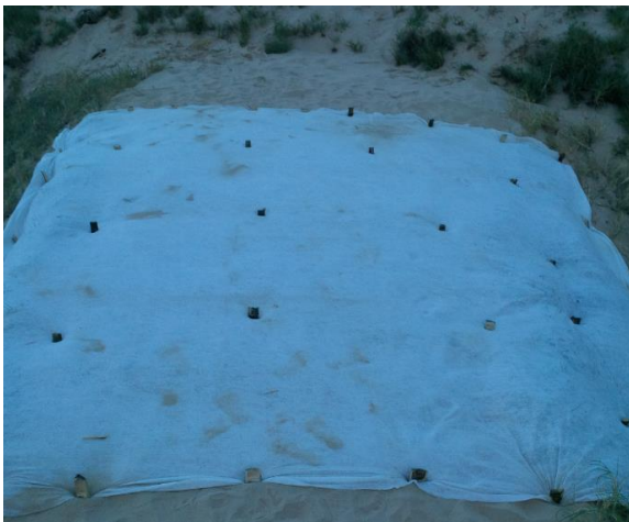
Hình 6. 44. Phủ mặt bằng vải địa kỹ thuật
