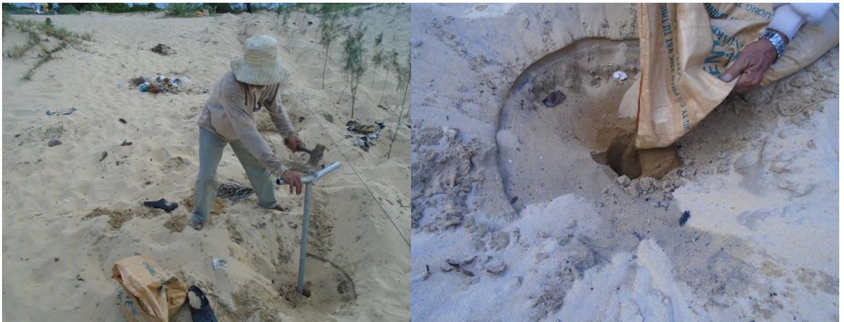
Hình 5. 68. Cải tạo hố đào bằng hố sét xã Cát Tiến – Phù Cát – Bình Định
