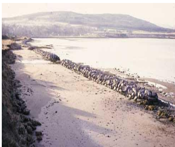
Hình 5. 9. Dạng công trình phá sóng gần bờ vừa được xây dựng
