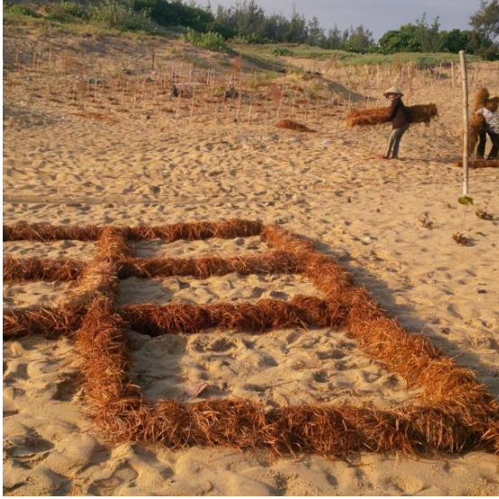
Hình 6. 46. Phủ mặt bằng ô rơm
