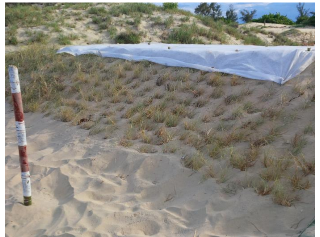
Hình 6. 45. Phủ mặt bằng thảm cỏ
