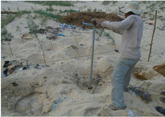
Bước 3. Khoan tạo lỗ cột sét
