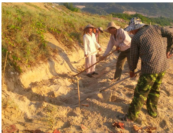
Hình 6. 40. Tạo chân cho công trình chống xói lở
