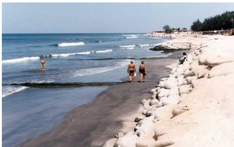
Hình 5. 18. Các túi cát được đặt trên bãi biển sát chân và trên 1 phần mái cồn cát
