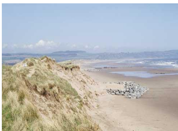
Hình 5. 5. Tạo mỏm nhân tạo bằng đá xếp
