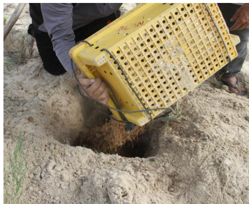
Hình 6. 58. Cải tạo hố đào bằng đất
