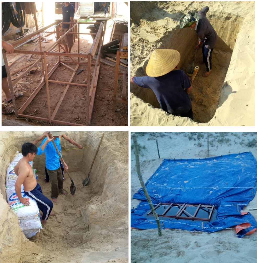
Hình 5. 77. Thí nghiệm thu trữ nước bằng bạt HDPE xã Cát Tiến – Phù Cát – Bình Định
