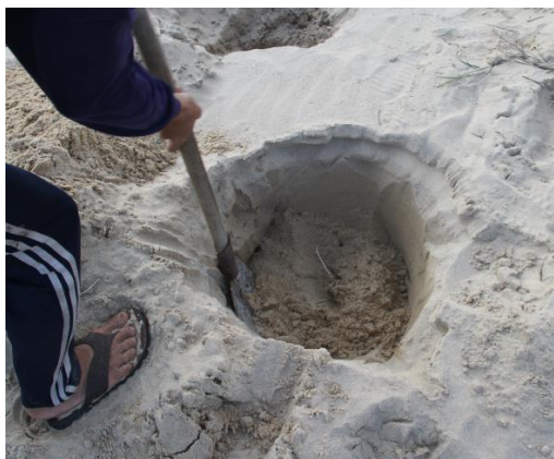
Hình 6. 57. Đào hố cải tạo
