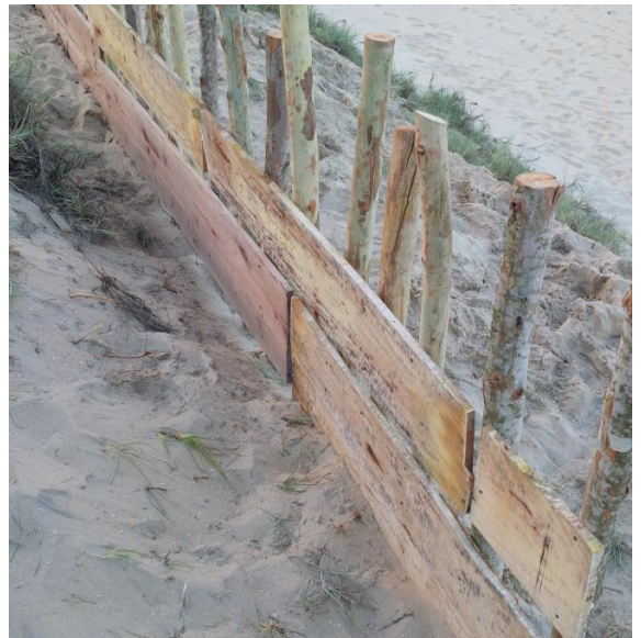
Hình 6. 56. Cọc hoàn thiện
