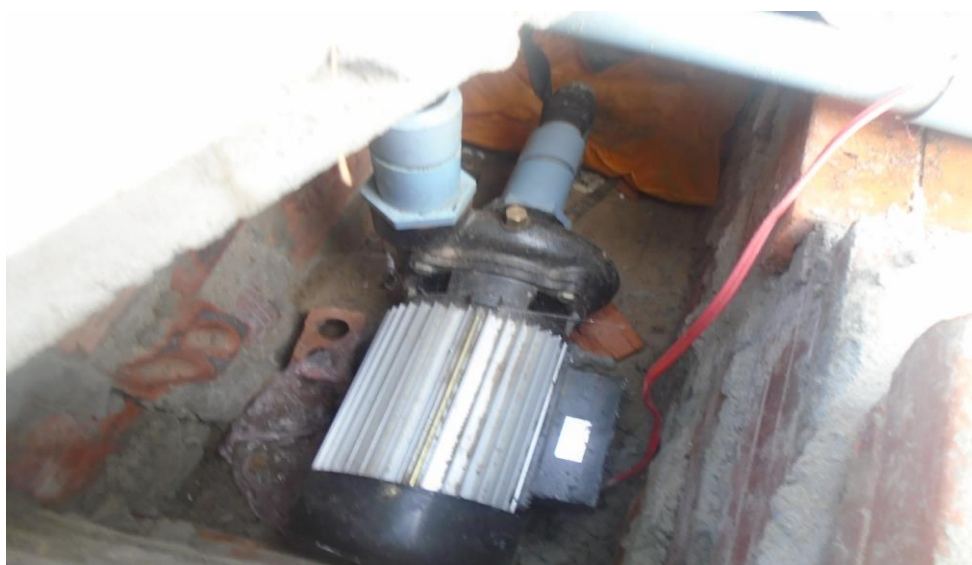
Hình 5. 78. Máy bơm đưa nước từ giếng khoan lên để tưới cây xã Cát Tiến – Phù Cát – Bình Định
