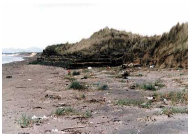
Hình 5. 6. Tạo mỏm bảo vệ nhân tạo bằng rọ đá
