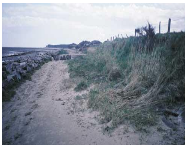
Hình 5. 10. Một khu vực công trình phá sóng gần bờ sau vài năm xây dựng (khu vực cồn cát khá ổn định)
