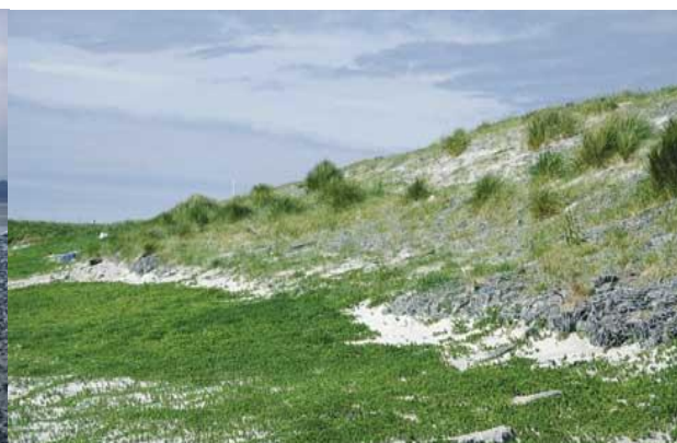
Hình 5. 15. Phần mái nghiêng rọ đá có tác dụng tích tụ cát và thảm phủ.
