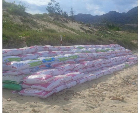
Hình 6. 43. Chống xói lở bằng bao tải
