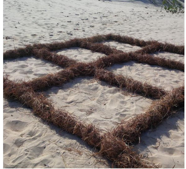
Hình 6. 46. Phủ mặt bằng ô rơm
