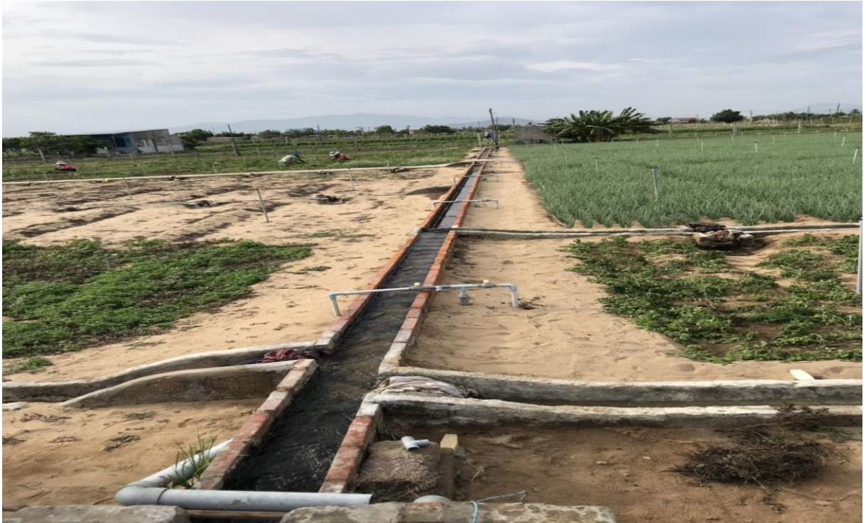
Hình 5. 18. Hệ thống kênh dẫn nước đưa nước tưới tiêu đến từng luống
