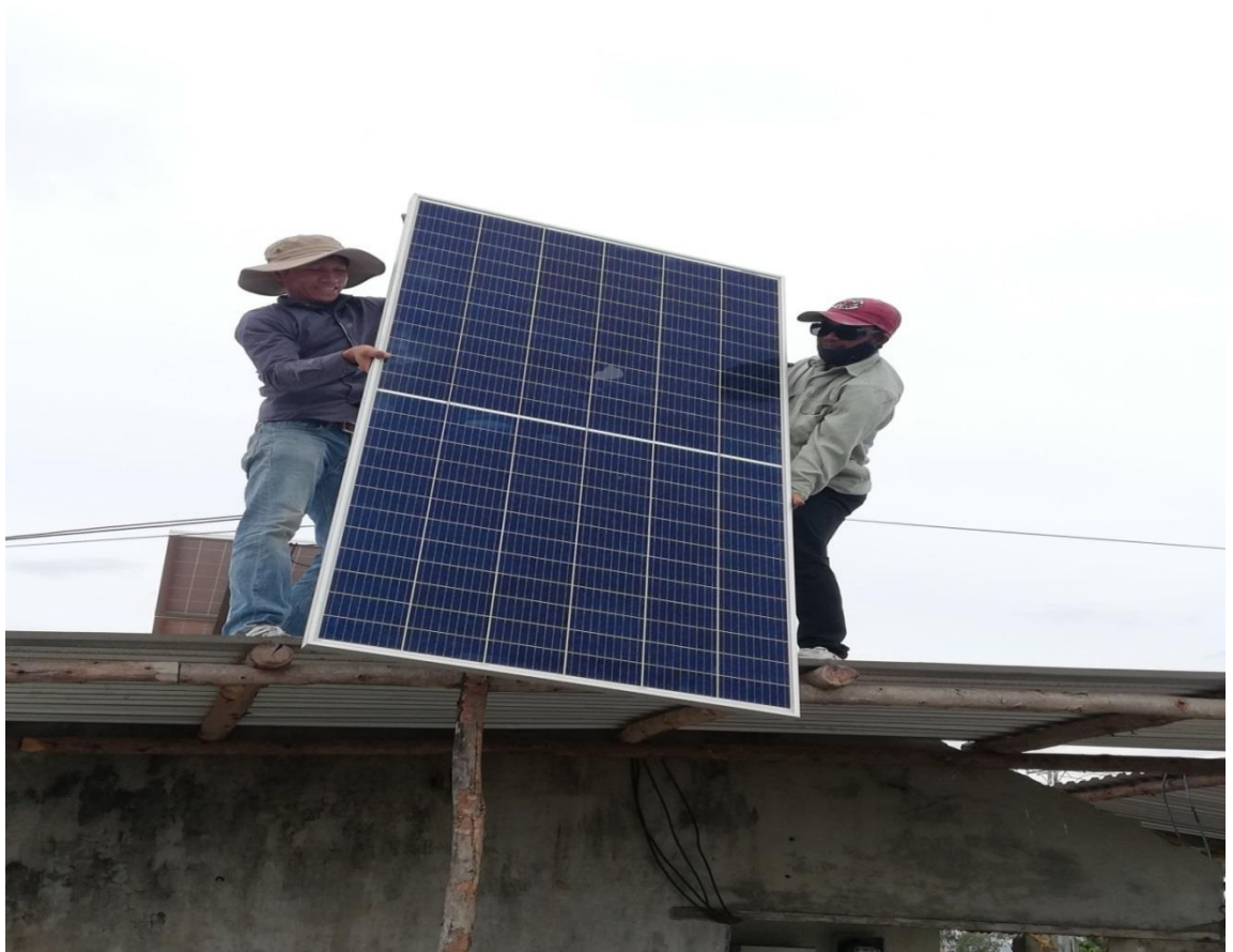
Hình 5. 5. Đội kỹ thuật đang tiến hành vận chuyển các tấm pin năng lượng mặt trời lên vị trí lắp đặt
