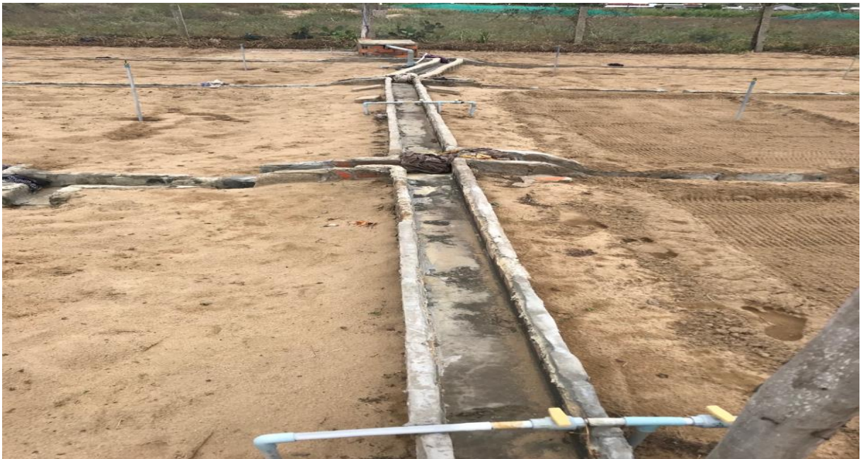
Hình 5. 11. Đường kênh dẫn nước vào các liếp
