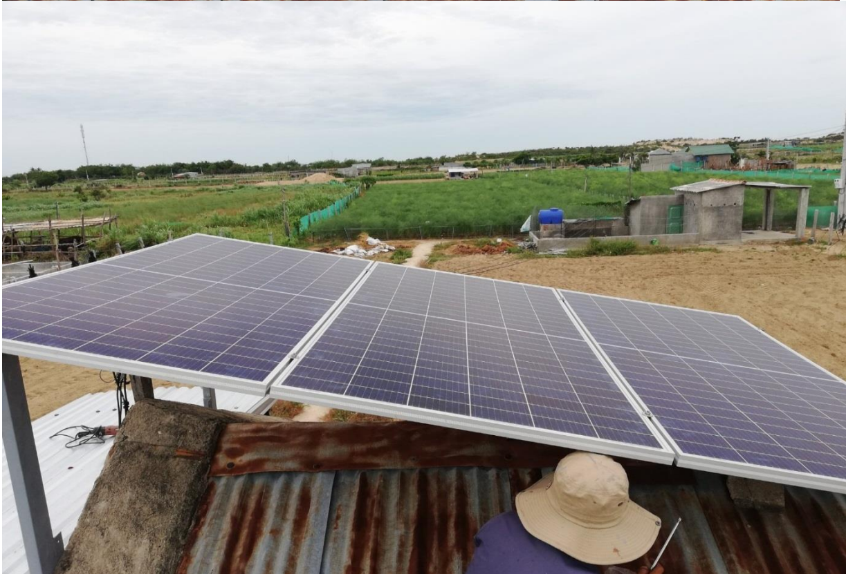
Hình 5. 6. Đội lắp đặt tiến hành lắp đặt các tấm pin năng lượng mặt trời
