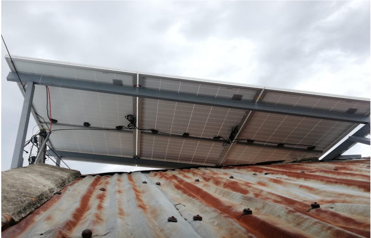
Hình 5. 7. Hệ thống năng lượng mặt trời sau khi được lắp đặt
