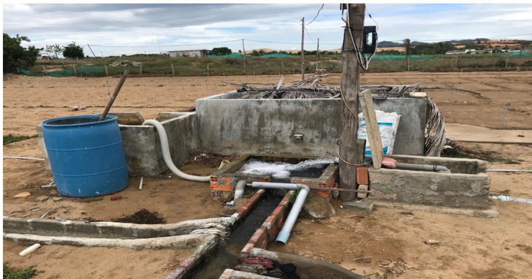
Hình 5. 1. Bể chứa nước 9 m 3 phục vụ tưới
