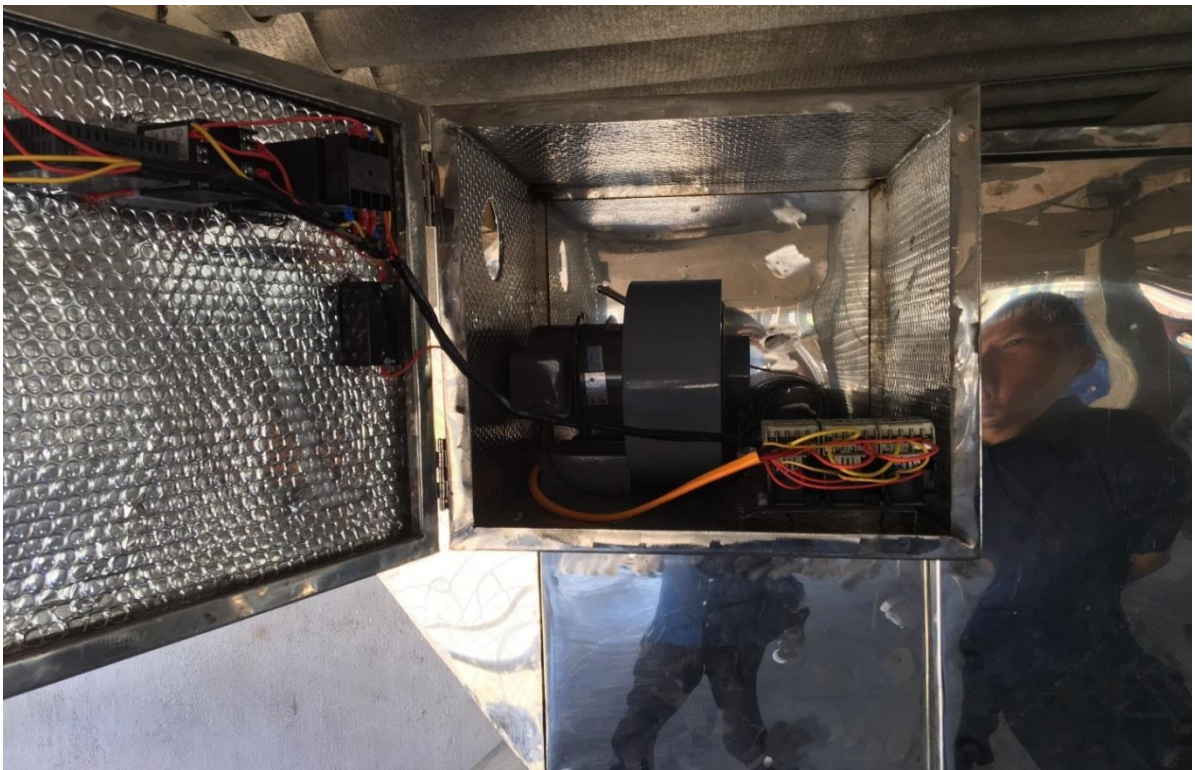
Hình 5. 33. Hệ thống quạt gió được lắp
