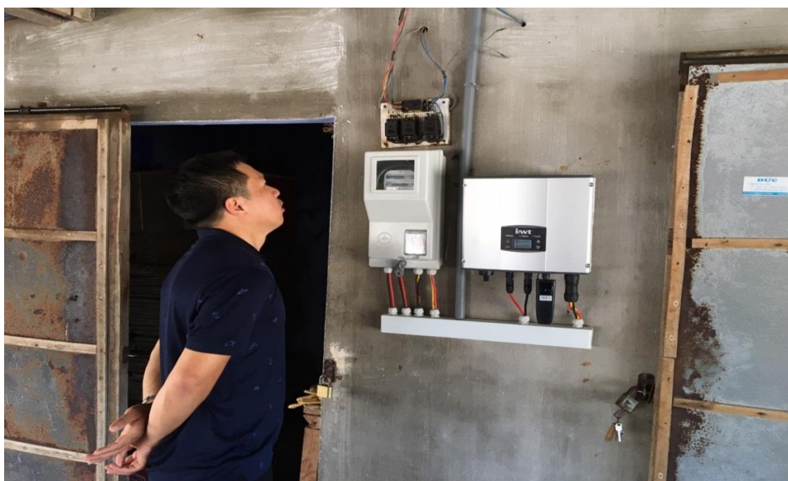
Hình 5. 41. Cán bộ kỹ thuật đang kiểm tra hệ thống năng lượng mặt trời
