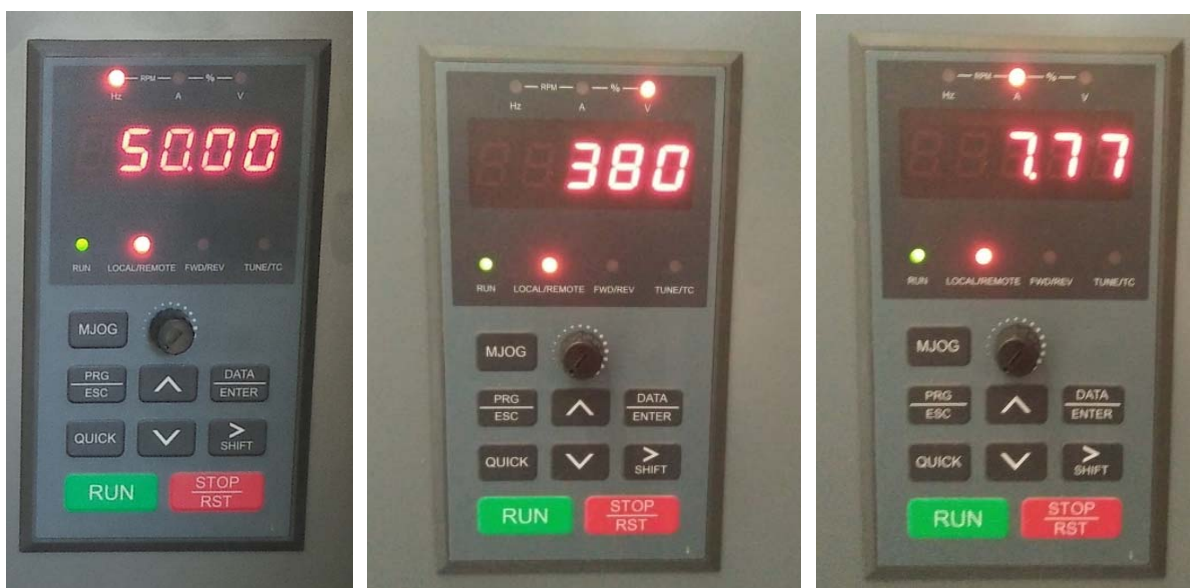
Hình 12: Thông số vận hành hệ thống tách ẩm 200L/ngày
