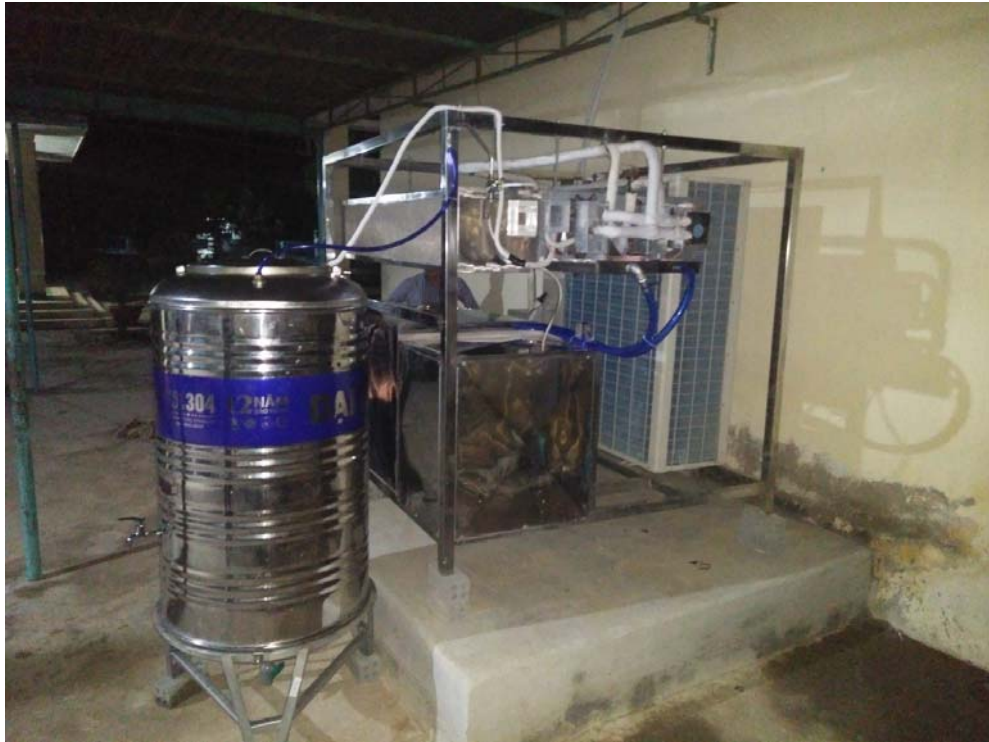
Hình 9: Hệ thống làm lạnh tách ẩm 200 L/ngày có trang bị bình chứa nước sạch
