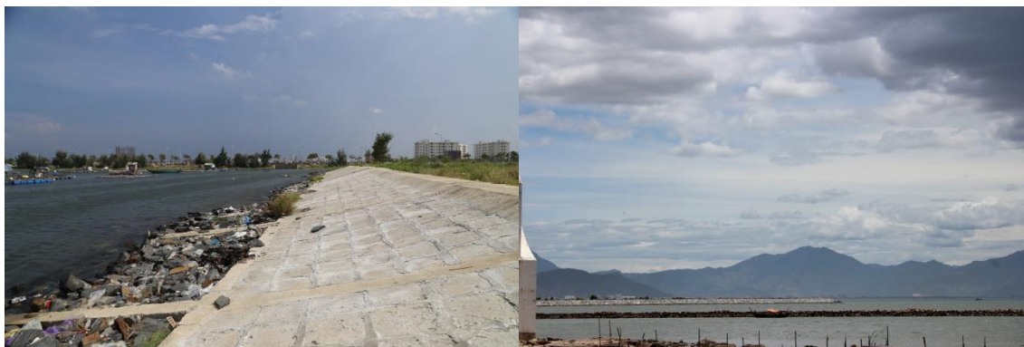
Hình 3.32. Kè chống sạt lở bờ biển ở cửa sông Hàn, Tp. Đà Nẵng
