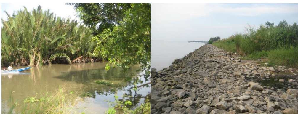
Hình 2.15. Rừng dừa nước ở phường Vĩnh Lợi (trái) và kè đá chống xói lở ở phường An Hoà (phải), Tp. Rạch Giá góp phần làm tăng KNTU
