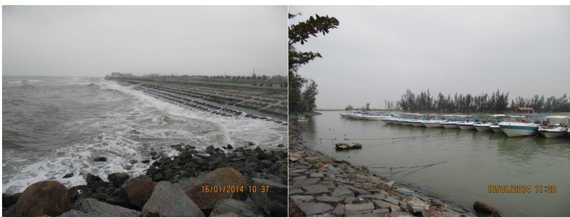
Hình 2.10. Kè chống sạt lở bờ biển và nơi neo đậu tàu thuyền ở Cửa Đại, Tp. Hội An
