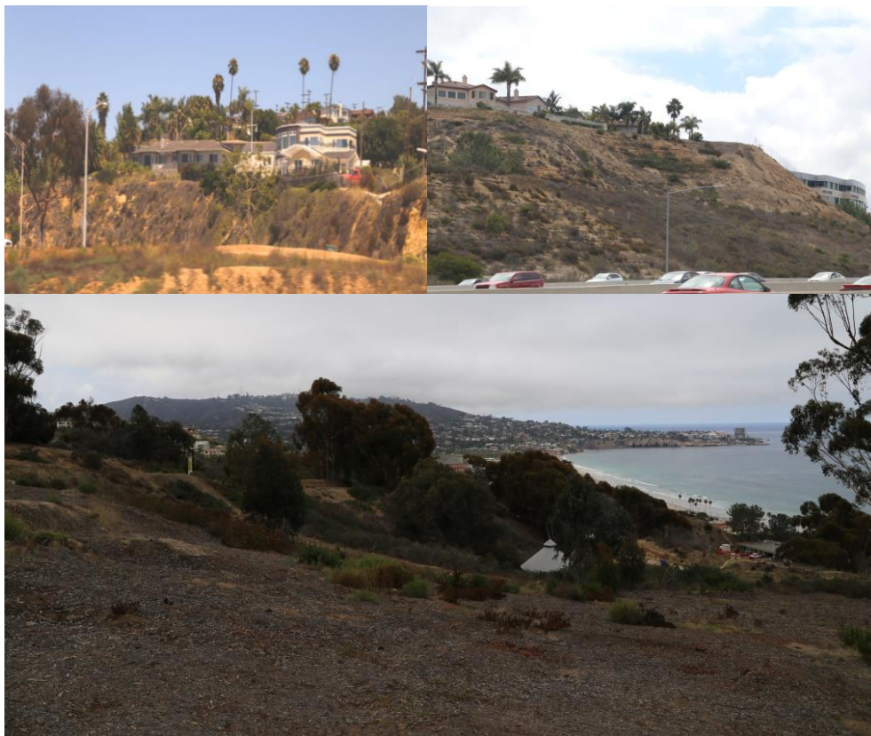
Hình 1.6. Các công trình được xây dựng ở Tp. San Diego theo triết lý toạ sơn (trên) và hưởng biển (dưới)
