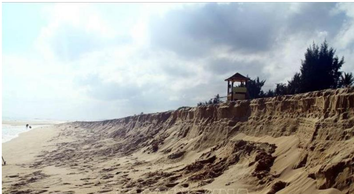
Tình trạng sạt lở tại bãi biển Bảo Ninh
