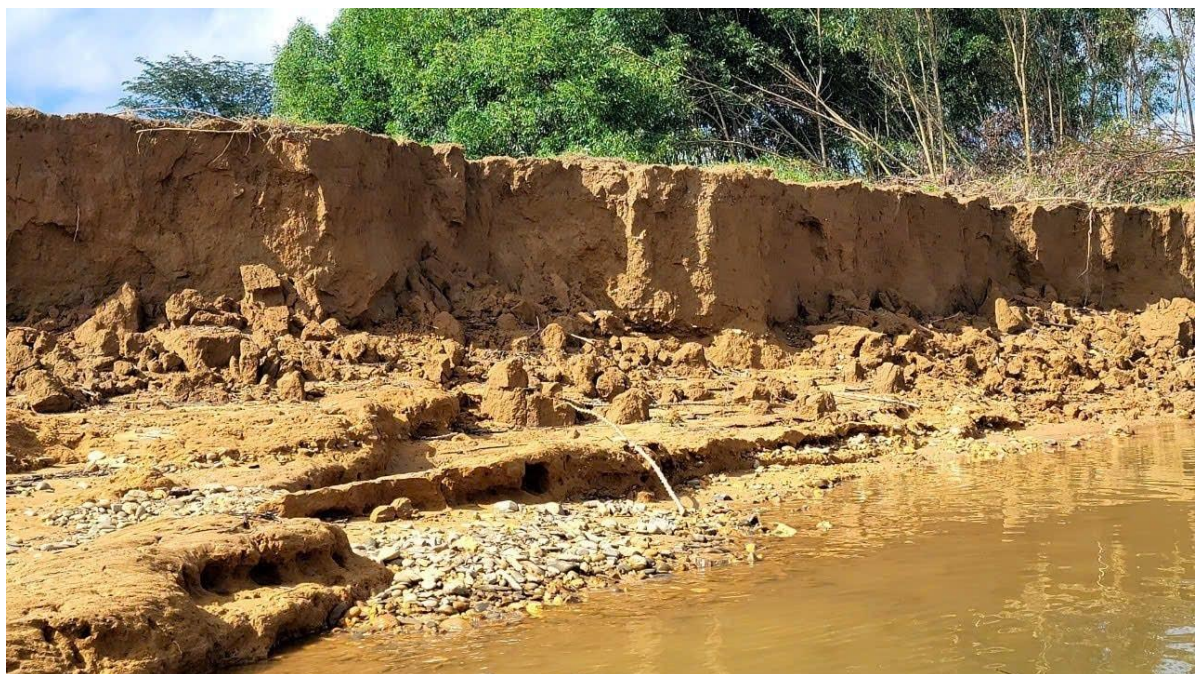
Sạt lở khiến dọc bờ sông Kiến Giang xuất hiện nhiều "hàm ếch".
