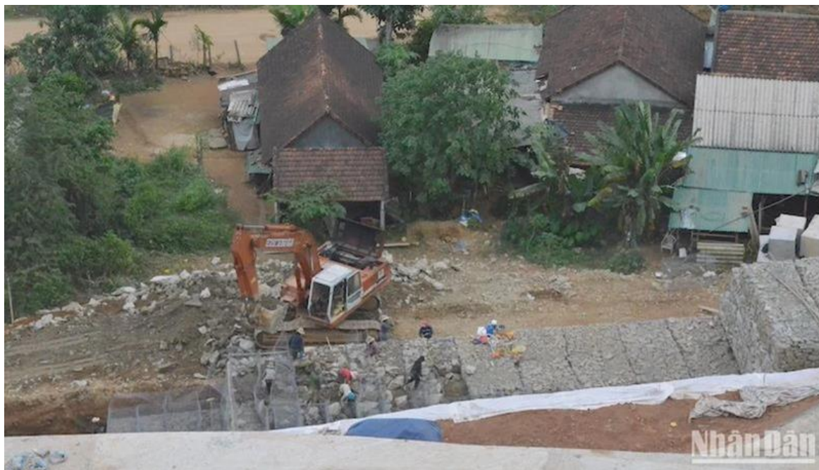
Thi công tường chắn rọ đá dưới chân núi Van Cà Vãi. Nguồn: Tạp chí Tài nguyên và Môi trường
