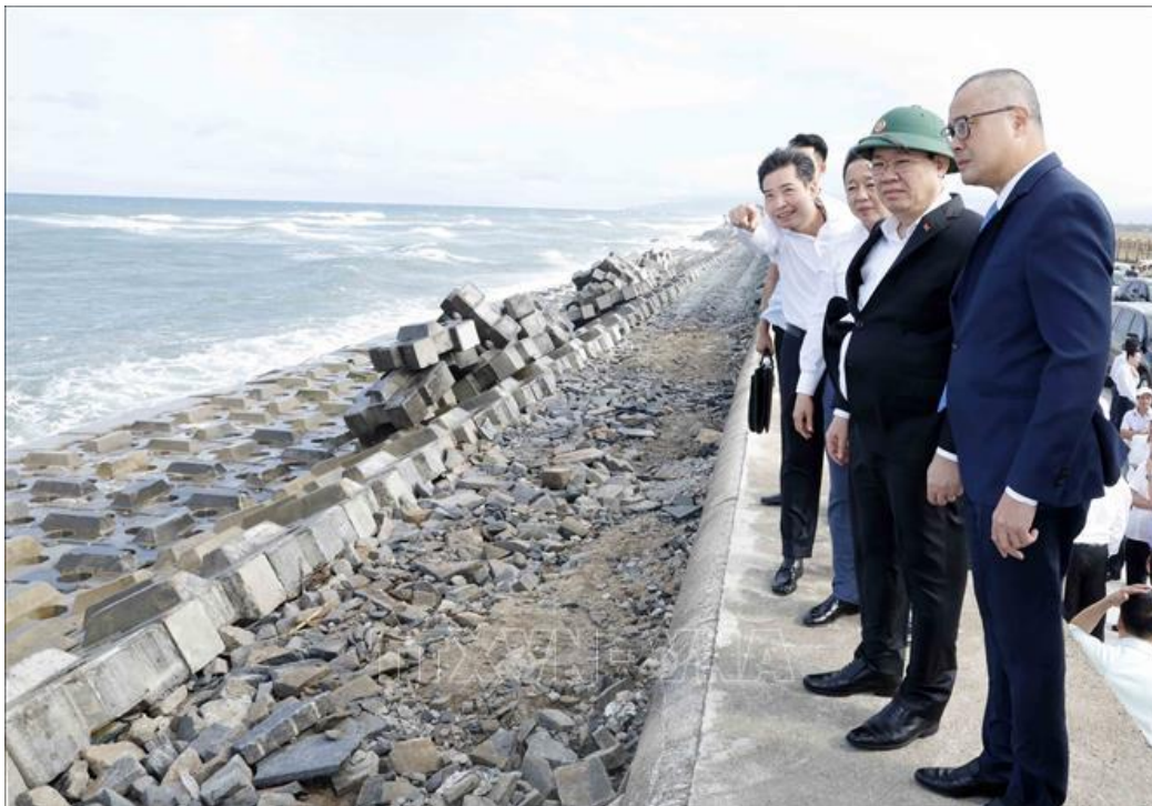
Kiểm tra kè chống xói lở khu vực ven bờ biển Xóm Rớ, phường Phú Đông, thành phố Tuy Hoà, tỉnh Phú Yên. Ảnh: Nhan Sáng/TTXVN
