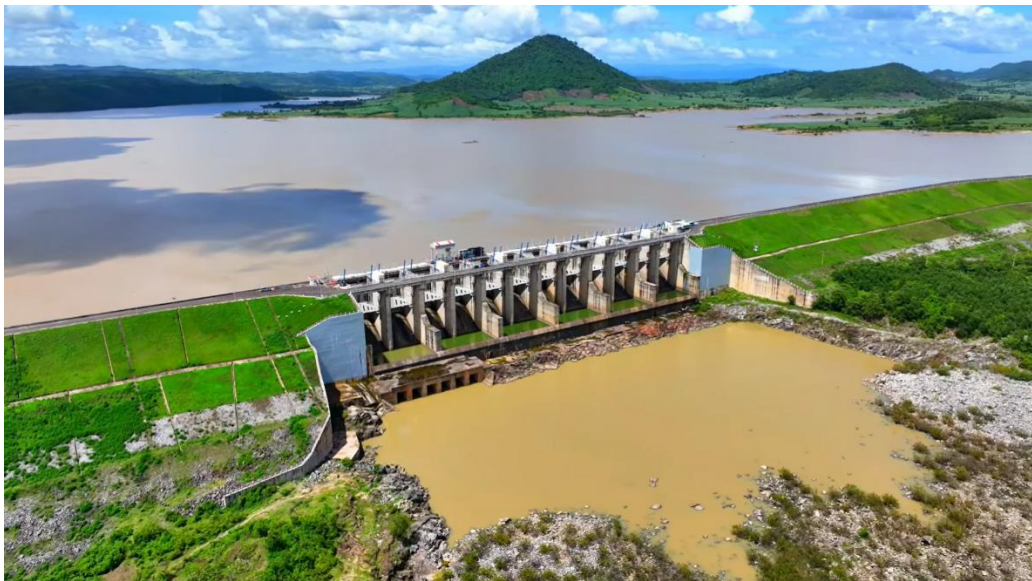
Đập thủy điện sông Ba Hạ (tỉnh Phú Yên)
